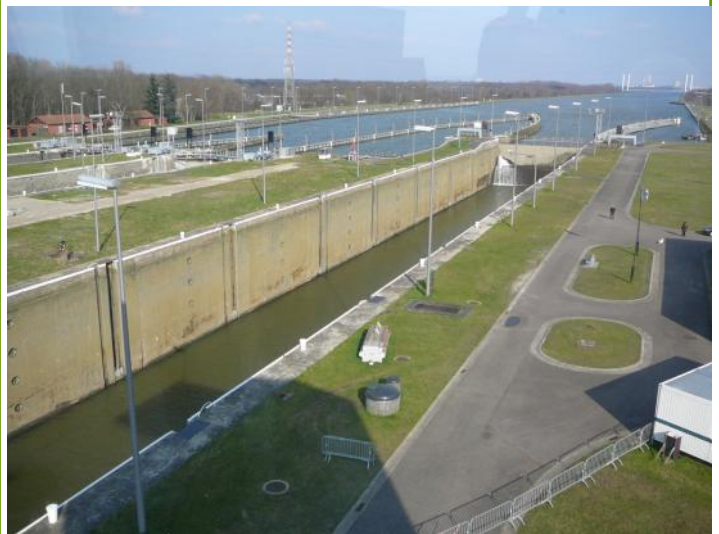
Een van de sluizen op het Albertkanaal
