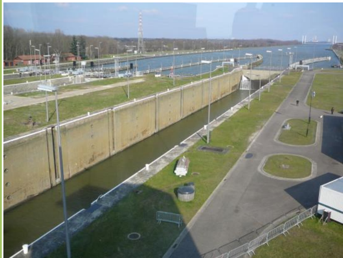
Une des écluses sur le Canal Albert, nv De Scheepvaart
