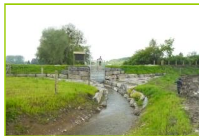
Kunstwerk om afvoeren te controleren, met doorstroomopening en nevengeul
