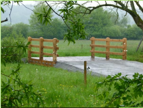
Ponceau pour éviter que le bétail piétine la rivière
