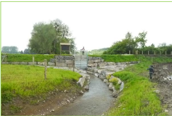
Ouvrage d'art de gestion du débit comprenant une vanne et un lit d'étiage
