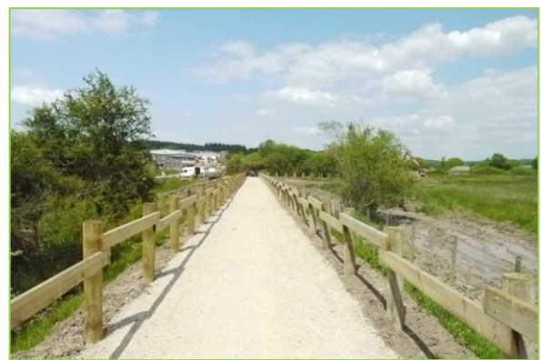
La digue avec la piste cyclo-piétonne
