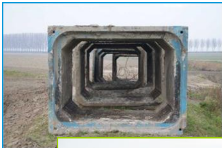
Dit wordt het vleermuizenhuis.
